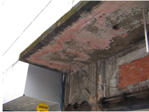
Vista interna de marquise localizada no centro de Joinville, situação atualmente encoberta por luminoso
