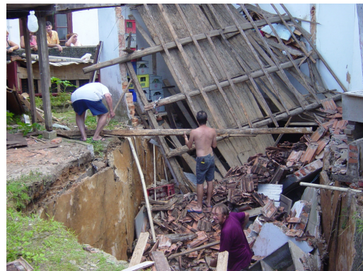
Desabamento de galeria (fonte - Defesa Civil de Ille)
