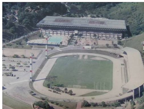
Figura 3 – Vista panorâmica das edificações objeto dos trabalhos
