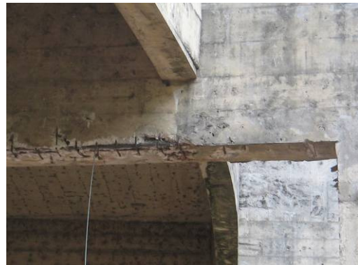
Figura 11 – Deslocamentos sob arquivancadas
