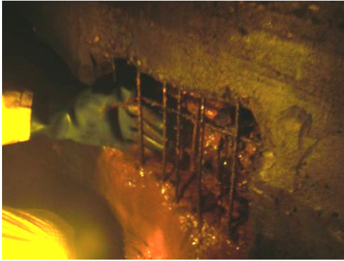
Figura 8 – Ninhos e armaduras exposta Galerias
